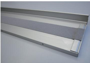
1. Auf die zu verbauende Fensterbank rückseitig, ca. 1cm von der Fassade zurückspringend das Format Drainage-Entkopplungsband aufkleben.
