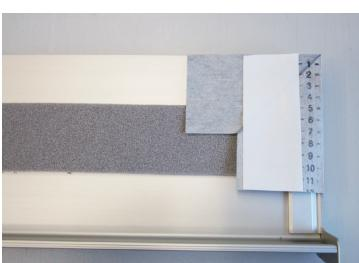
2. Die Format Drainage-Ecken entsprechend der Ausladung vom Fensterstock bis Ende Fassadendämmung ablängen. Kleberabdeckung des 20 mm Selbstklebestreifens an der kurzen, inneren Seite der Ecke entfernen und Ecken rechts und links der Fensterbank verkleben.
