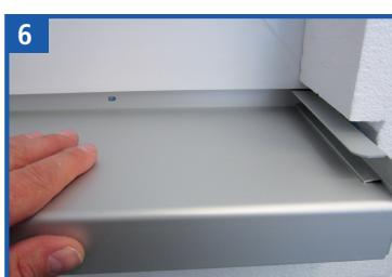
1. Die Lage des Format Drainage-Systems vom Fensterstock bis Außenkante Fassadendämmung einmessen.
